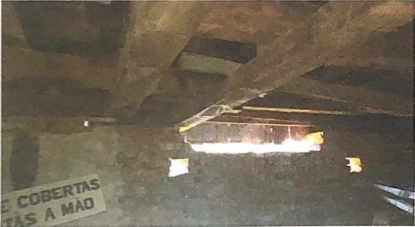
Detalhe da estrutura de madeira apoio assoalho
